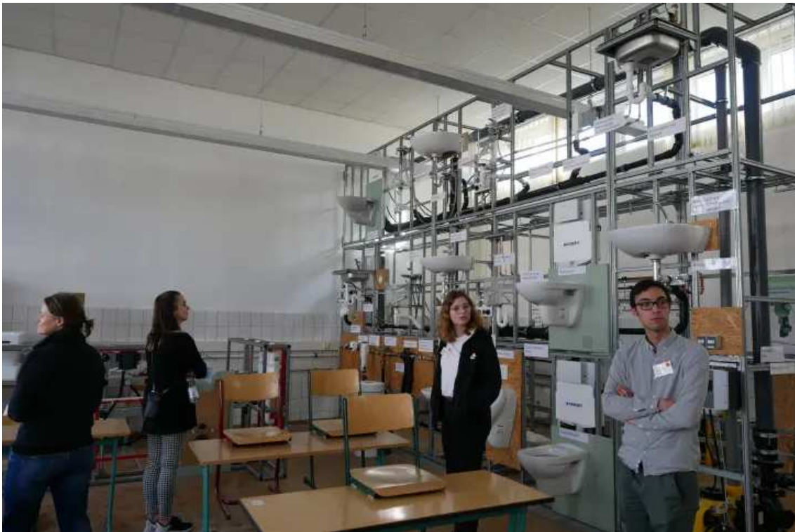
Die Werkhalle für die Anlagentechniker begeistert die Studenten. FOTO: KATHARINA GOLZE
